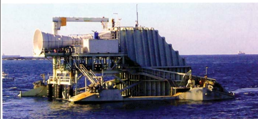
نصب افزاری ی تبدیل انرژی موج با ظرفیت ۵۰۰ کیلووات در اقیانوس در نزدیکی پورت کمبلا در استرالیا که می تواند برق سالانه ی ۵۰۰ مگاوات را فراهم کند.
