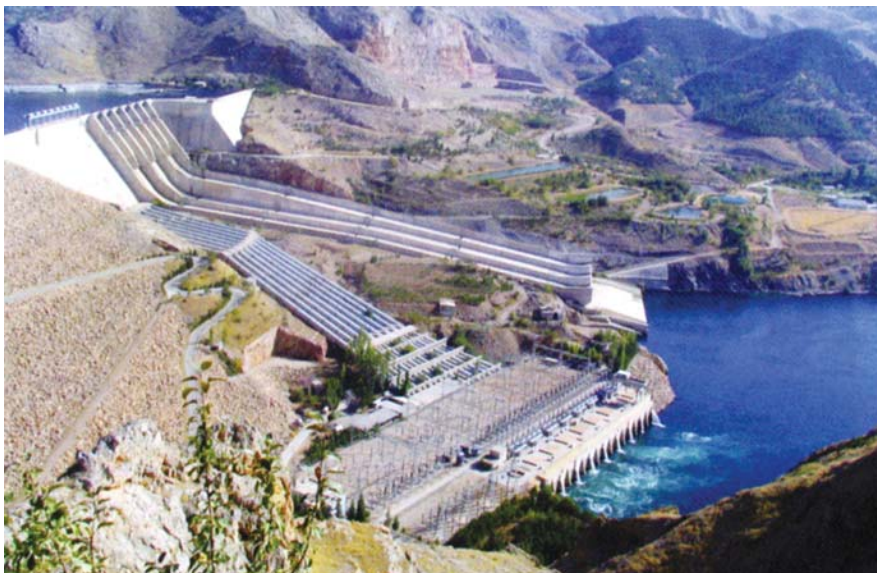
شکل ۴: در نتیجه ی استفاده از چارچوب تدوین شده توسط شرکت برق فرانسه، پروژه ی ۱۳۵۰ مگاواتی کبان در رودخانه ی فرات در ترکیه به عنوان بهترین پروژه ی بازسازی و ارتقاء این کشور انتخاب شد.
