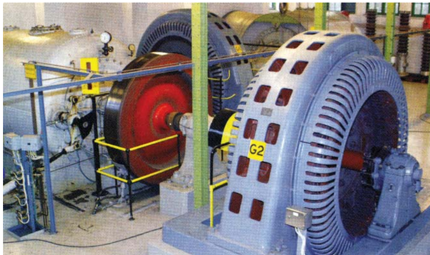
شرکت واستربرگسلاگنز کرافت ای بی تامین تجهیزات توربین ژنراتور برای بازسازی نیروگاه برق آبی ۳۰۶ مگاواتی لودویکا در سوئد را به کنسرسیومی متشکل از شرکت اتریشی کاسلر و شرکت آلمانی لویید دینامورک سپرد.
