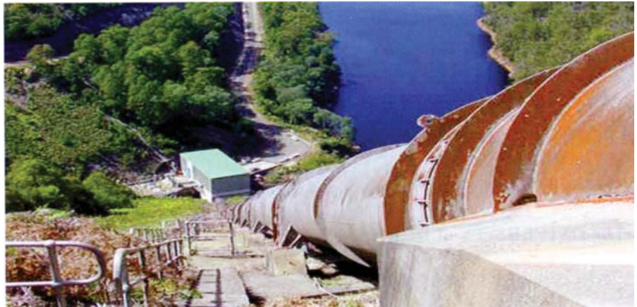
آزمایش پاک سازی لوله ی پرفشار در نیروگاه ۳۲ مگاواتی ویلموت تولید را آگیاوات ساعت بهبود داد که مطابق انتظار هیدروتاسمانیا بود. بنابراین سایر لوله های پرفشار نیز در صف پاک سازی مشابهی قرار داده شدند.
